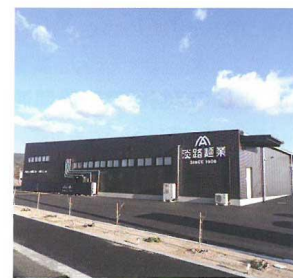
40種類の生パスタを製造する新工場
