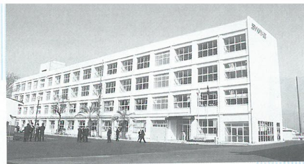
旧北淡東中学校にある北淡工場
